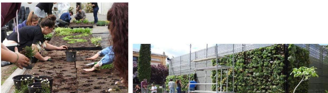
Figura 4. Preparación de un módulo vegetal e instalación sobre la malla metálica. Fuente propia
