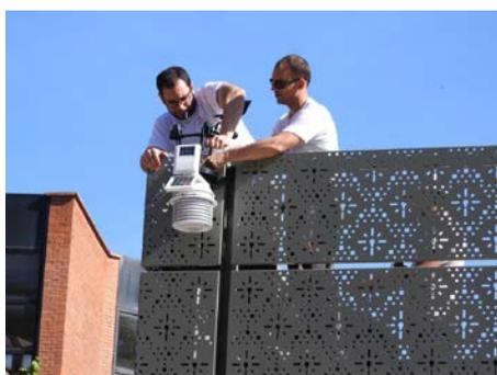
Figura 7. Instalación de estación meteorológica en la parte superior del edificio. Fuente propia
